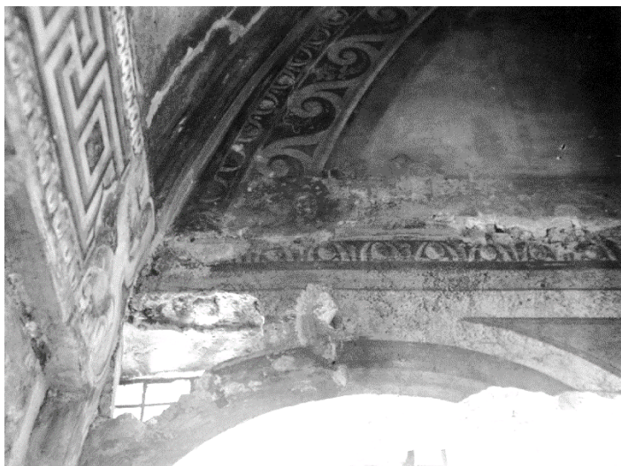
Certosa di Milano, particolare del degrado della controfacciata in una fotografia degli anni trenta.
