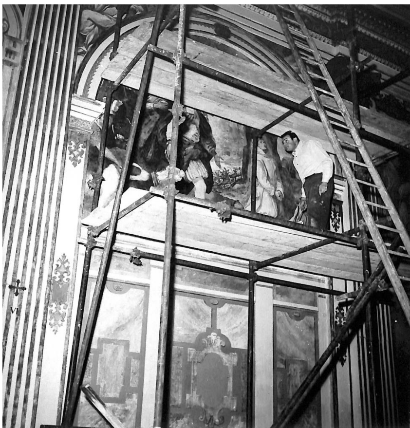
Certosa di Milano, particolare del piccolo cantiere realizzato per effettuare lo strappo e il restauro della pellicola pittorica della VI lunetta raffigurante l'Incontro tra San Bruno e il conte Ruggero di Calabria. L'affresco, al termine dei lavori, è ricollocato nella sua sede originaria.
