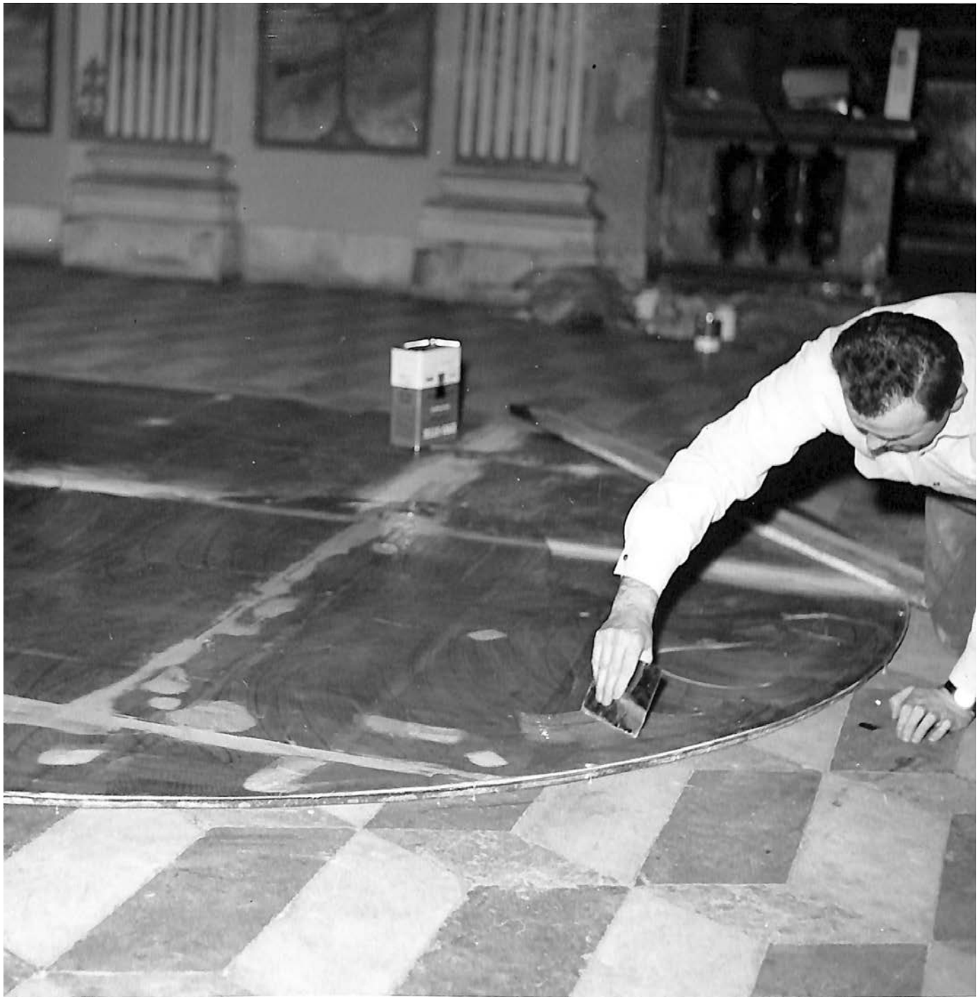
Certosa di Milano, particolare delle operazioni di stesura del mastice EVO-STIK per far aderire la tela dell'affresco strappato sul telaio in tamburato di laminato in poliestere, irrigidito dal telaio metallico costruito dai fratelli Colli, progettato dal prof. Ottemi della Rotta.
